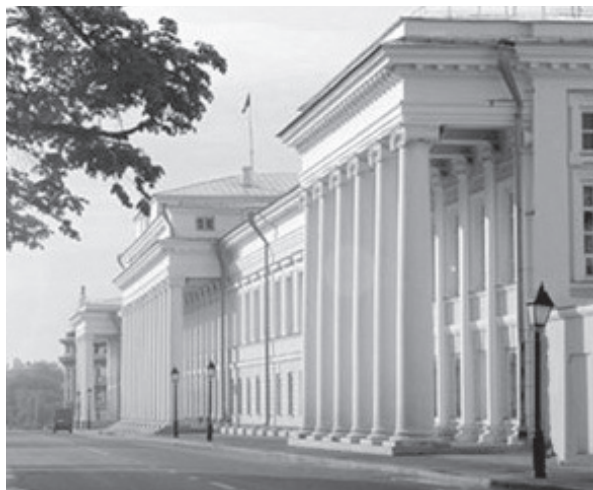
Рис. 2. Главное здание Казанского (Приволжского) федерального университета.
