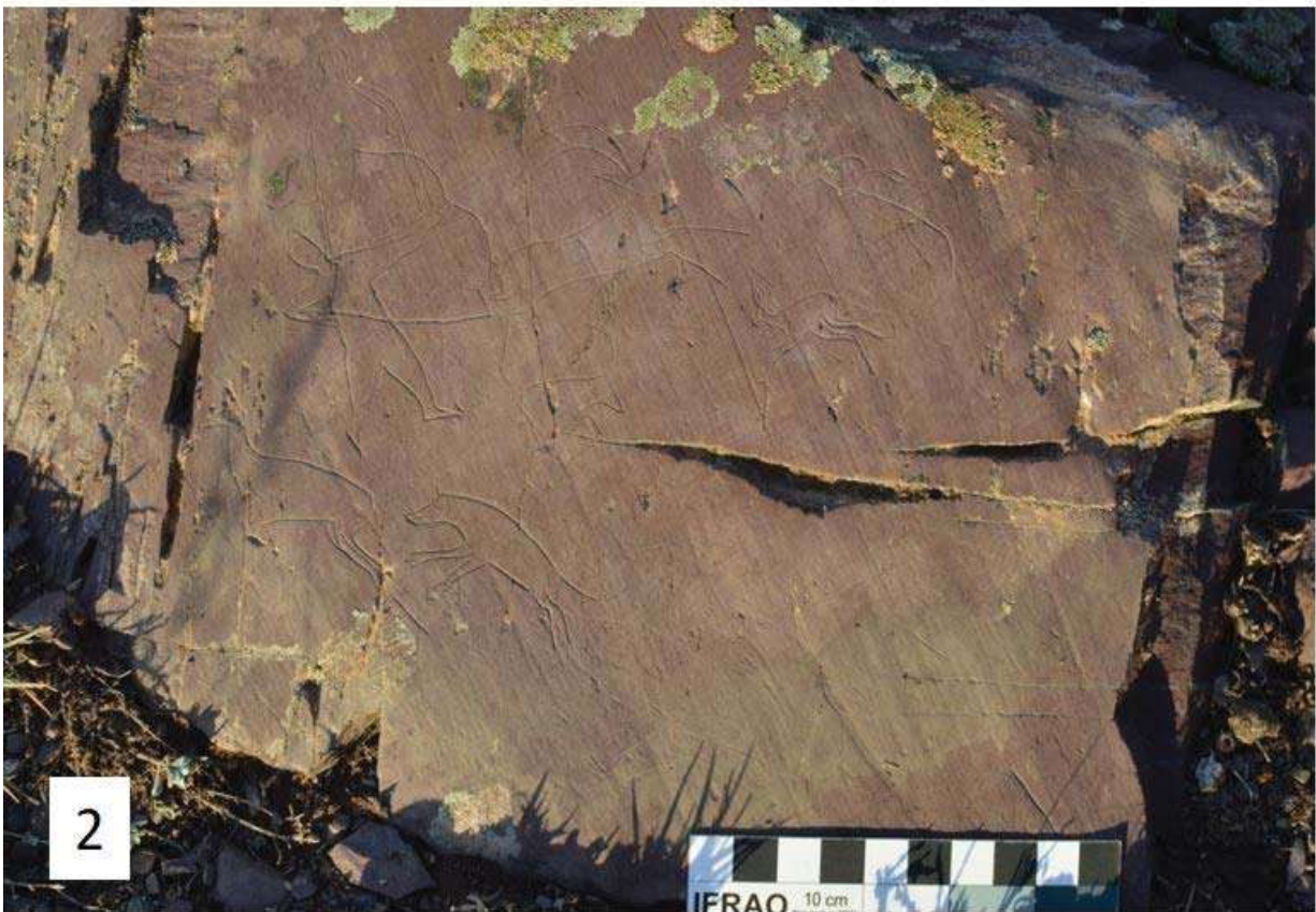
Рис. 5. Крупные трещины, каверны и литофиты на плоскости памятника Дялбак. Fig. 5. Large crack, caverns and lithophytes on the plane of Dyalbak monument.
