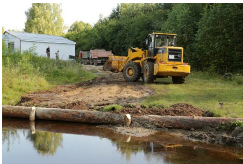
Рис. 2. Укладка несыпучего грунта на эрозионном участке реки, выравнивание для последующего посева многолетних трав.
