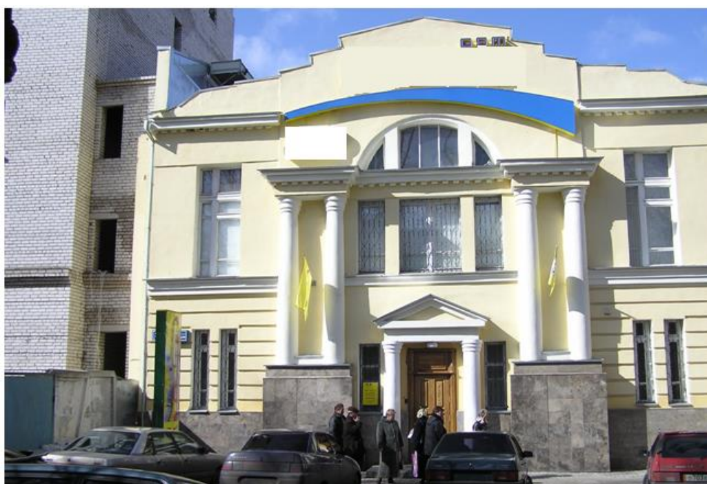
Рис. 1. Строительство нового здания вплотную к уже построенному
