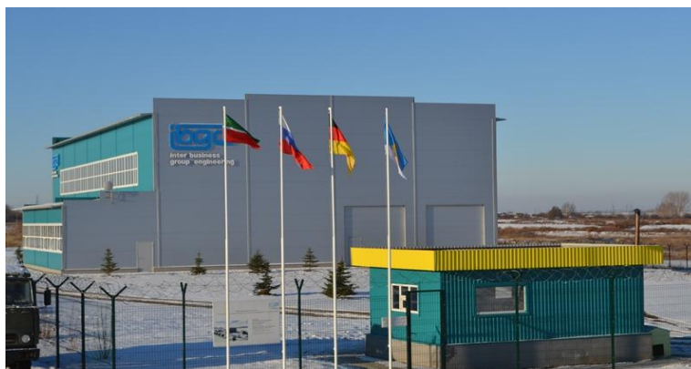
Рисунок 1. - Комплекс переработки углеводородсодержащих отходов в г. Набережные Челны.
