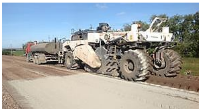
Рис. 2. Перемешивание щебня, нефтяного шлама, портландцемента и воды ресайклером
