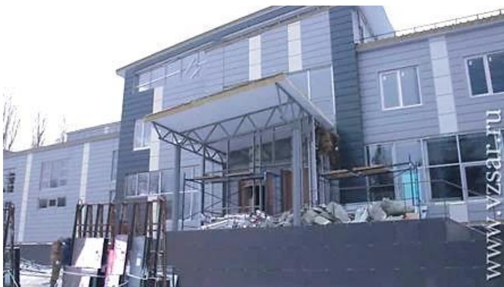
Рис. 4. Бадминтонный центр в г. Саратове на ул. Чернышевского
