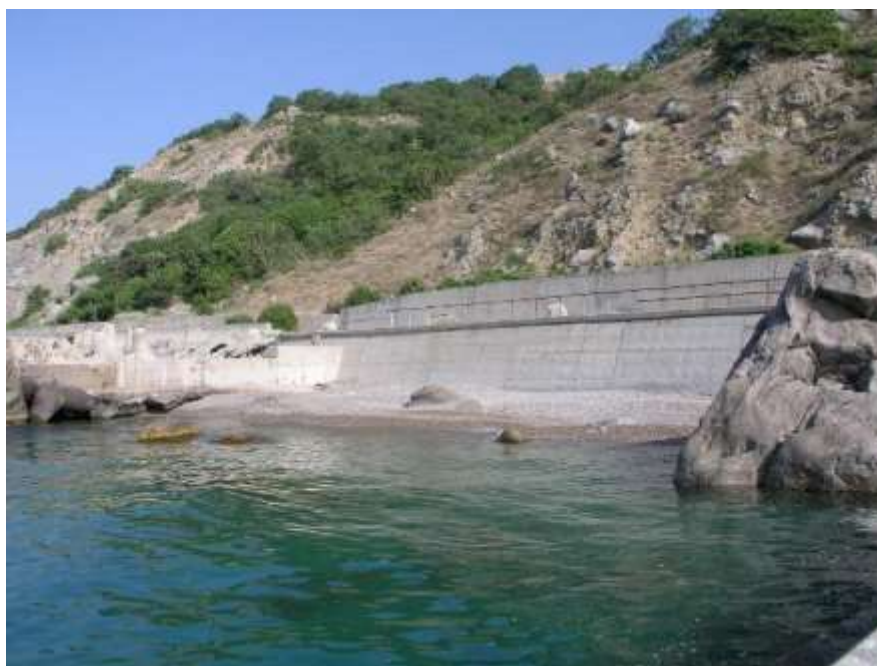
Рис. 2. Бетонирование морского берега.
