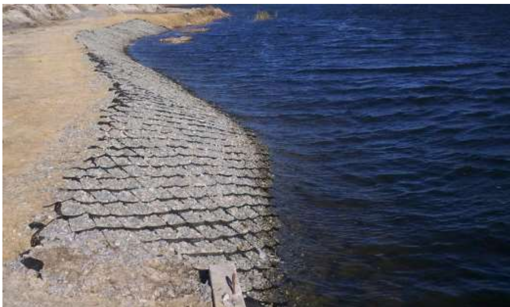
Рис.9. Георешетка с заполнением щебнем.
