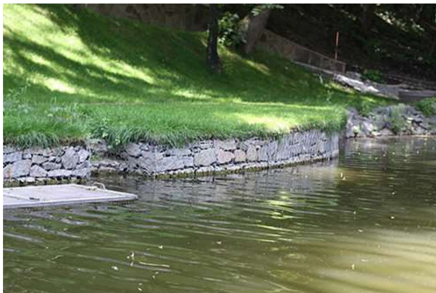
Рис. 4. Габионы в берегоукреплении.
