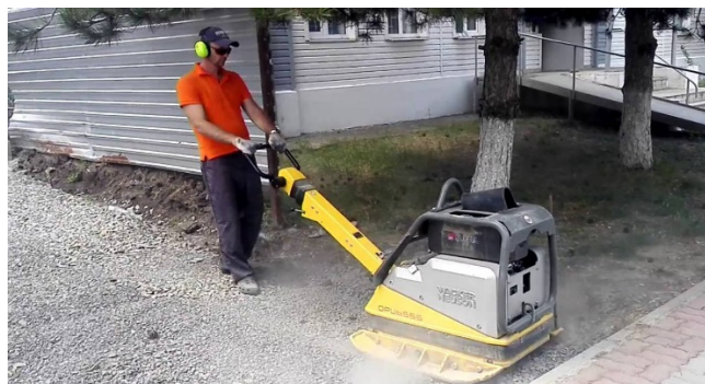
Рисунок 7 – Трамбование щебня
