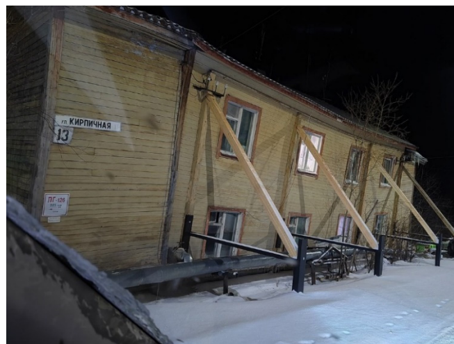
Рис. 2. Аварийная деформация эксплуатируемого здания на многолетнемёрзлых грунтах.
