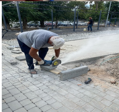
Рисунок 2;3 – Работа угловой шлифовальной машиной
