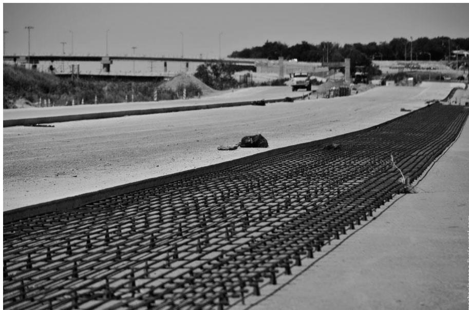
Рисунок 2 - Армирование дороги для грузовых автомобилей
