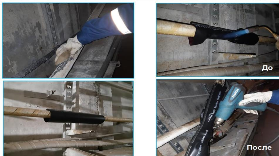
Рисунок 2. Работа с термоусаживаемыми муфтами
