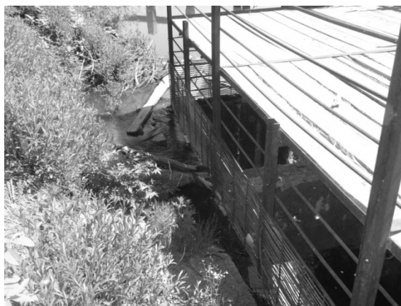
Рис. 3. Деформация верхового откоса земляной плотины на участке сопряжения с шахтой
