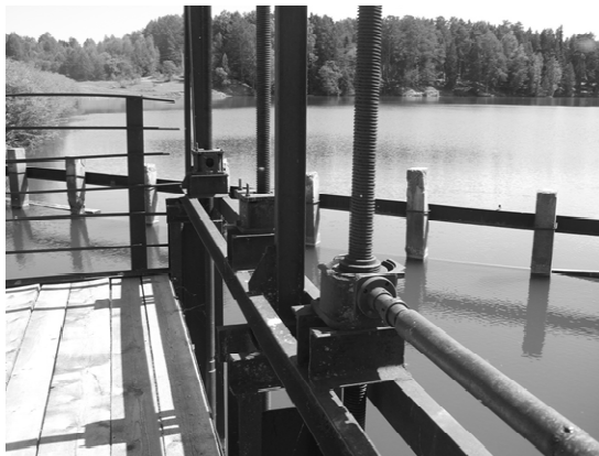
Рис. 2. Верх шахты водосброса и ледозащита
