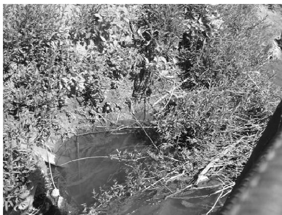
Рис. 1. Провал грунта на верховом откосе плотины у водосброса
