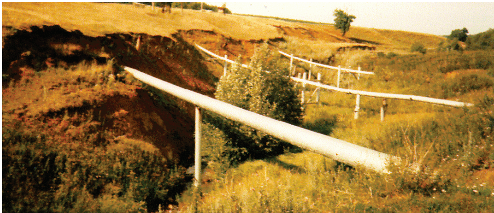
Рис. 16. Нефтепроводы через ручей
