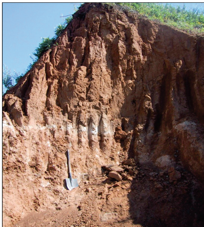
Рис. 12. Пример расчистки, пройденной в суглинках
