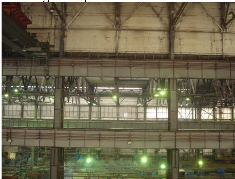
Рис.3 Подкрановые конструкции (двойные пути)
