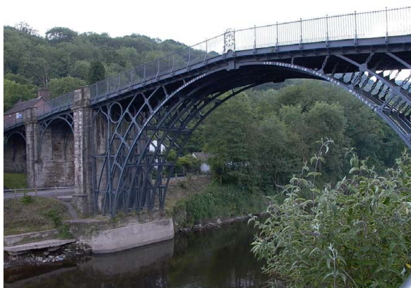
Рис. 3. А. Дерби. Первый в мире металлический мост на р. Северен, Великобритания, 1779 г.
