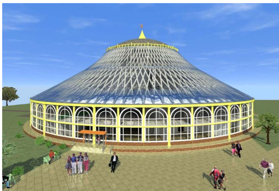
Рис. 1. Выставочный павильон с висячим покрытием инженера В.Г. Шухова в Нижнем Новгороде
