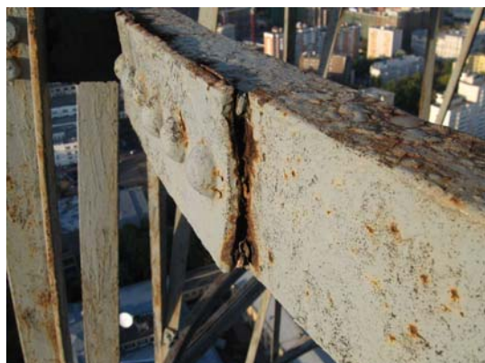
Рис. 3. Искривление накладки в стыке промежуточного кольца
