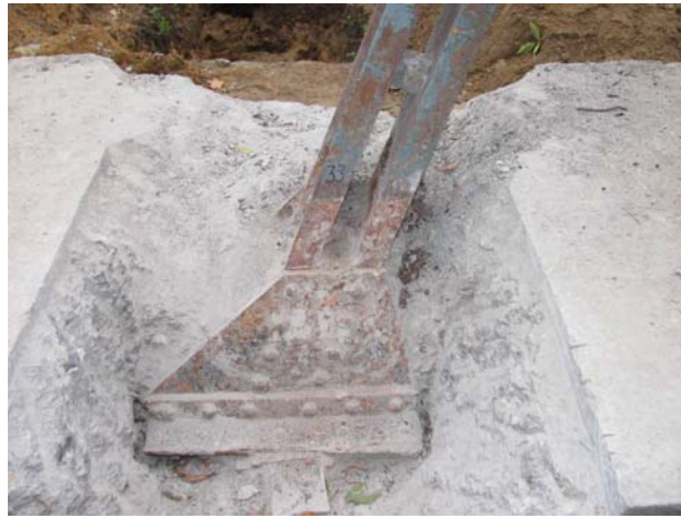
Рис. 5. Узел опирания стойки после удаления бетона
