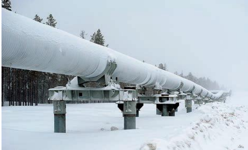
Рисунок 1 Участок завершеного строительства
