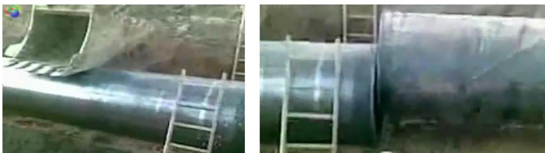
Рисунок 1. Смещение концов трубопровода в результате его резки
