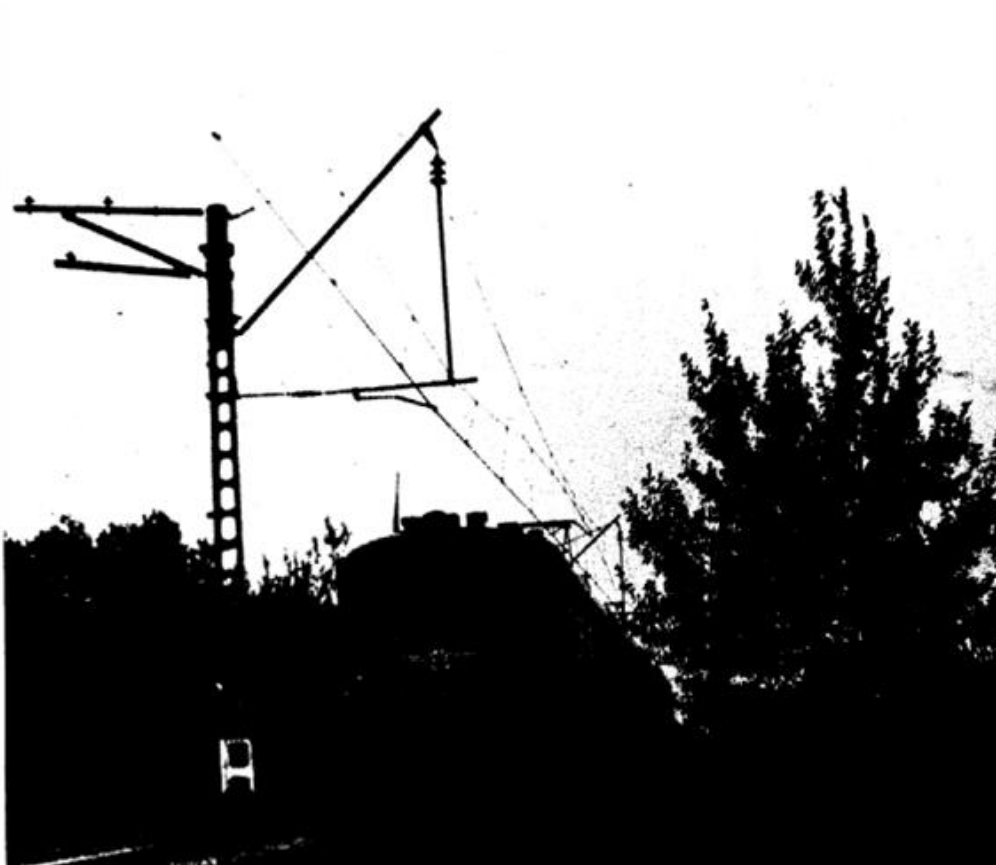
Рис. 4. Общий вид промежуточного пролета длиной 70 м вертикальной вантовой подвески ПБСМ-95 + М-120 + 2МФ-100
