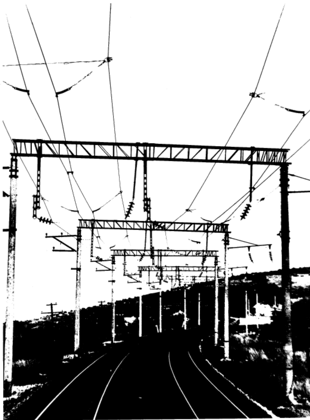
Рис. 8. Пространственно-ромбовидная подвеска
