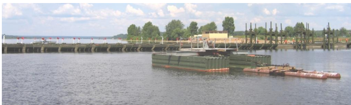
Рис. 6. Якорница, смонтированная на секциях понтонов НЖМ-56
