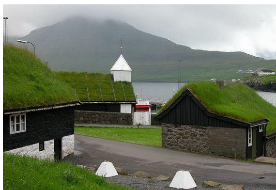
Рис. 2. Экстенсивное озеленение
