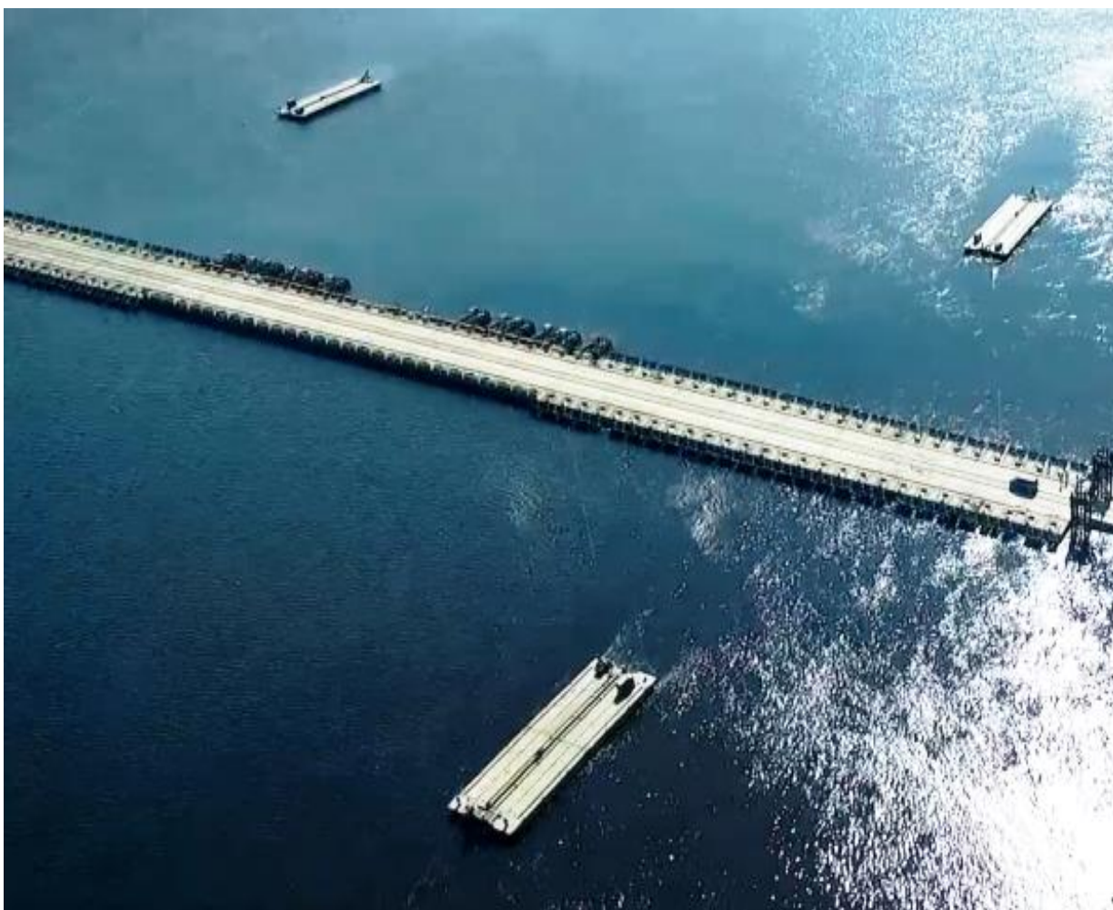
Рис. 9. Общий вид поперечного закрепления наплавного моста из имущества МЛЖ-ВФ-ВТ с якорницами из понтонов марки П
