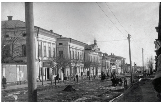
Фото 2. Казанская улица, комплекс зданий Уездного и женского училищ
