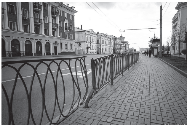
Рис. 1 Пример ограждения проезжей части от тротуара, г. Казань
