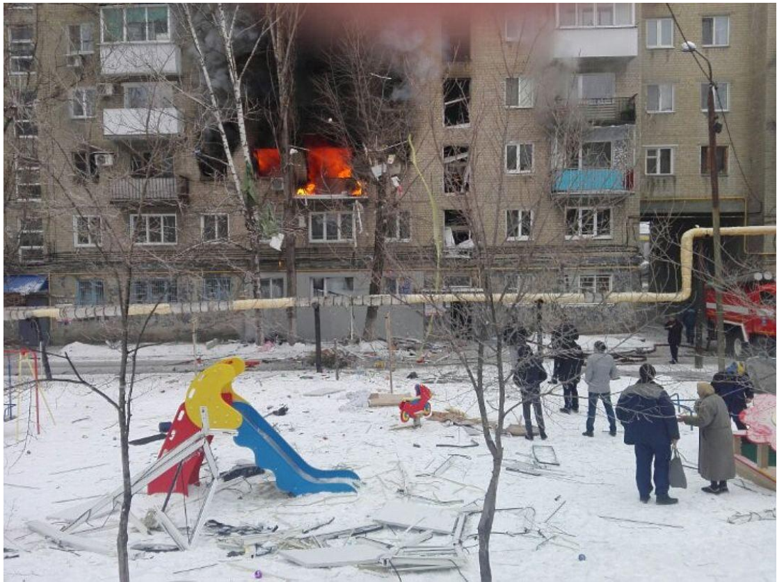
Рис. 1. Взрыв бытового газа в 6-ти этажном доме в г. Саратов
