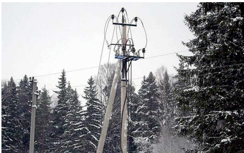
Рис.1. Обрыв высоковольтных проводов из-за гололеда в Республике Татарстан в 2014 году
